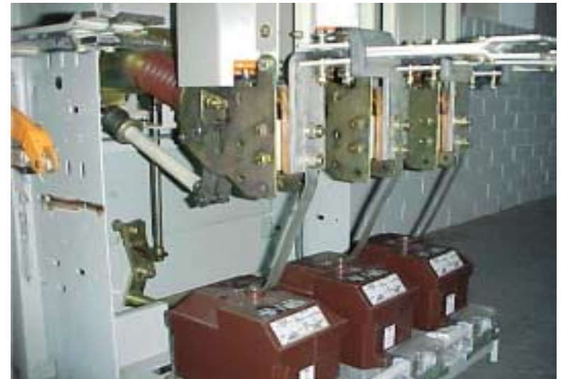
11kV Switchgear
